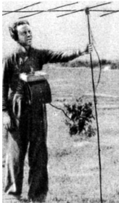
К. Фехтел с аппаратурой на 144 МГц (приемник 1-V-1 – на двух сетевых пальчиковых лампах и одном кристаллическом триоде П1Е, т.н. облегченная 4-х эл. антенна), с. Бортнычи (около Киева), 1957 г.
